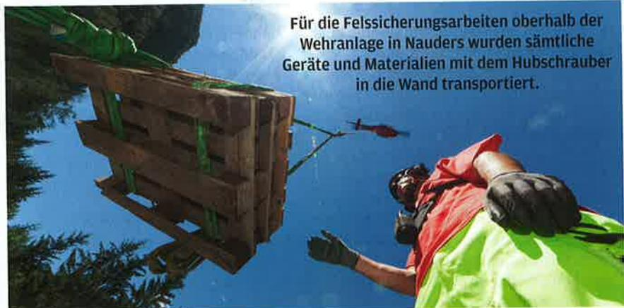
Für die Felssicherungsarbeiten oberhalb der Wehranlage in Nauders wurden sämtliche Geräte und Materialien mit dem Hubschrauber in die Wand transportiert.
